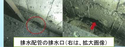
排水配管の排水口(右は、拡大画像)
