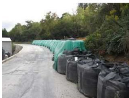
敷地境界に土嚢を設置
